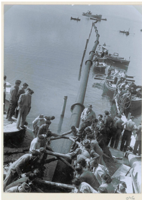
Pose de la conduite dans le lac Léman pour alimenter l'usine de Lutry Photo : Musée historique de Lausanne
